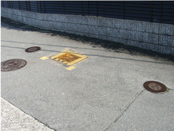
図7 道路面の凹凸(路上のマンホールや道路の亀裂に凹凸がある)
